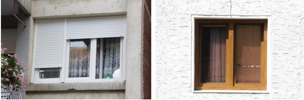
Slika 6: PVC stolarija ostakljena sa dva (lijevo) i tri (desno) stakla
