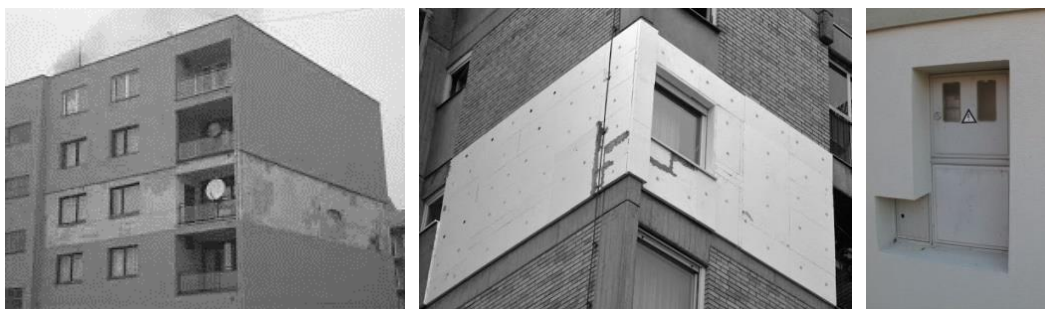
Slika 32: Primjeri toplinskih mostova kod loše izvedenih sanacija postojećih objekata
