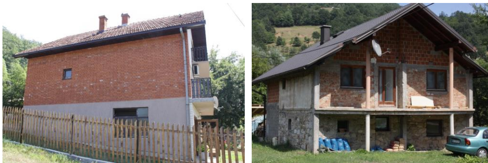
Slika 2: Primjeri stambenih objekata sa vanjskim zidovima izvedenim od različitih vrsta materijala
