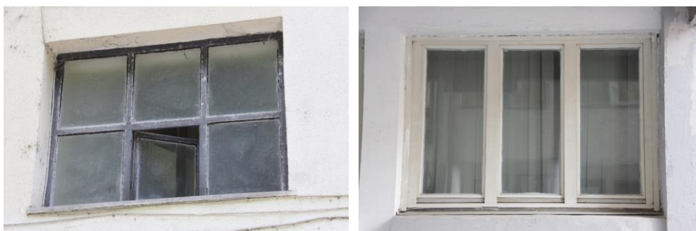
Slika 5: Drvena stolarija ostakljena sa jednim (lijevo) i dva (desno) stakla
