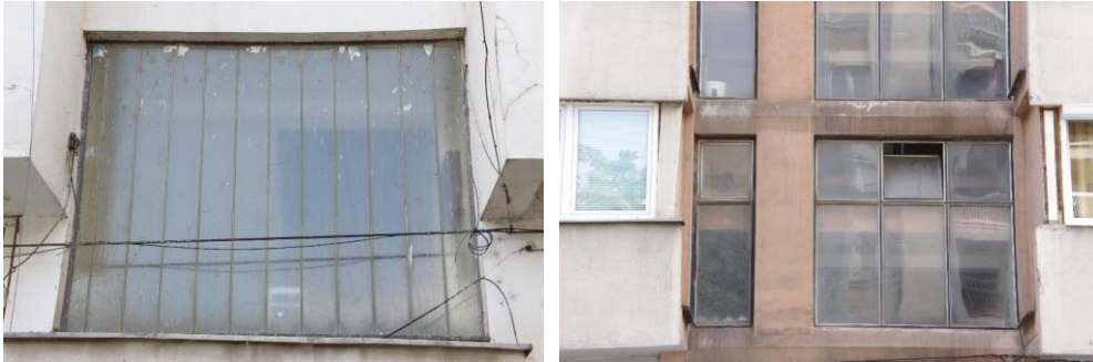
Slika 7: Otvori od kopelita (lijevo) i čelično-aluminijumski prozori (desno)
