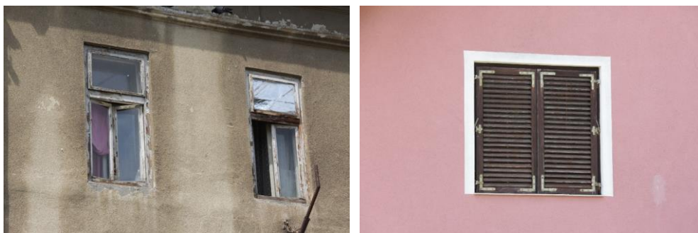
Slika 4: Drveni kutijasti prozori (lijevo) i drveni dvokrilni prozor (desno)
