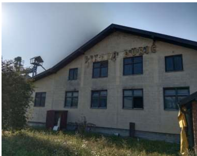
Slika 2. Izgled objekta predmetne pekare
