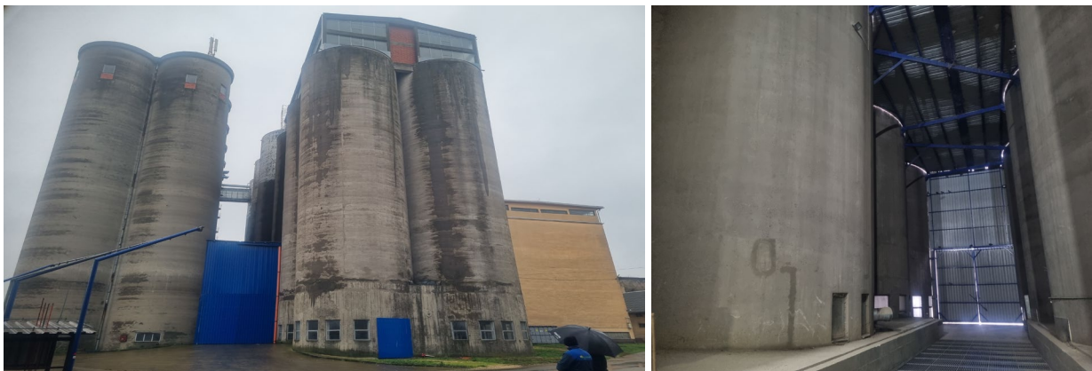
Slika br. 11 i 12. Izgled silosa
