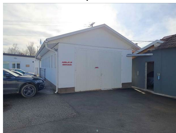
Slika 7. Objekat broj 5, poslovno-proizvodni objekat
