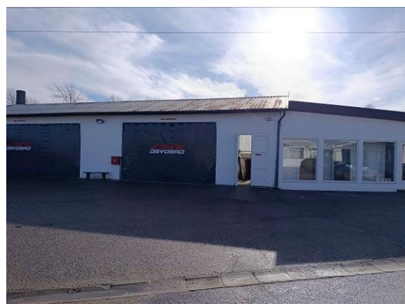
Slika 3. Objekta broj 1, poslovni objekat, administracija i skladište sa nadstrešnicom
