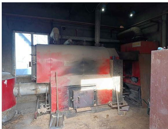
Slika 7a. Toplovodni kotao snage 400 kW
