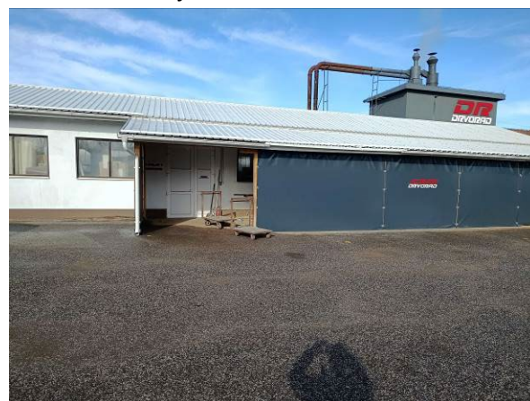
Slika 5. Objekat broj 3, poslovno-proizvodni objekat
