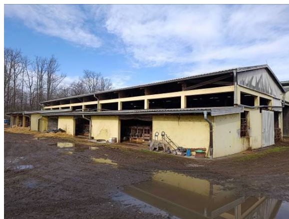
Slika 3. Izgled zadnje strane farme sa prostorom za tov teladi
