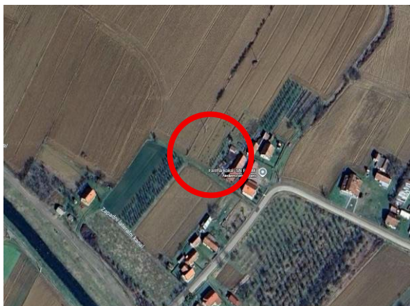
Slika 1. Lokacija gradnje buduće farme
