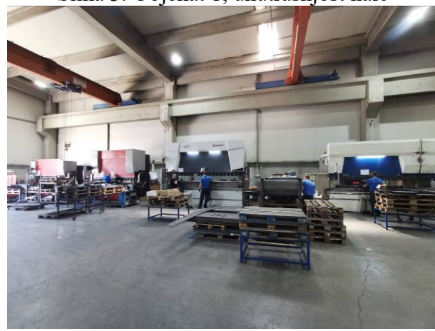
Slika 5. Objekt 3, radni prostor i oprema
